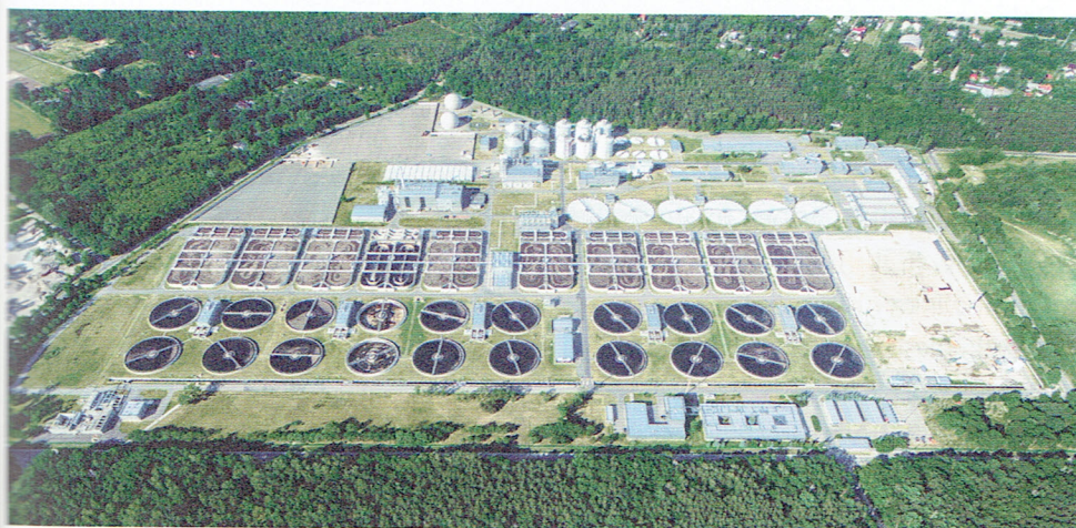
Ryc. VII.5.7. Zakład oczyszczania ścieków komunalnych Czapka (Warszawa).
